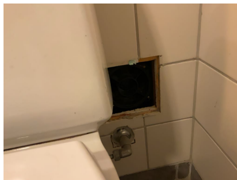
Stakeluke på bad i 1. etg.
