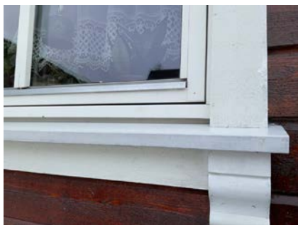
Omrammingsbord er ført ned til beslag under vindu
