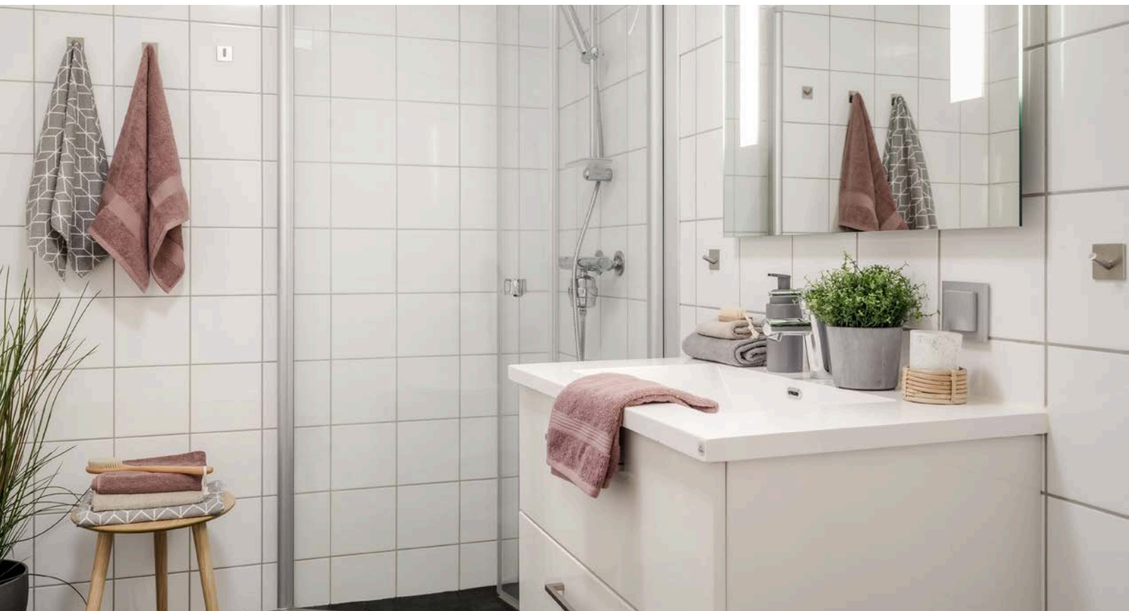
Badet har dusjnise med innfellbare dusjdører og vegghengt dusjbatteri.
