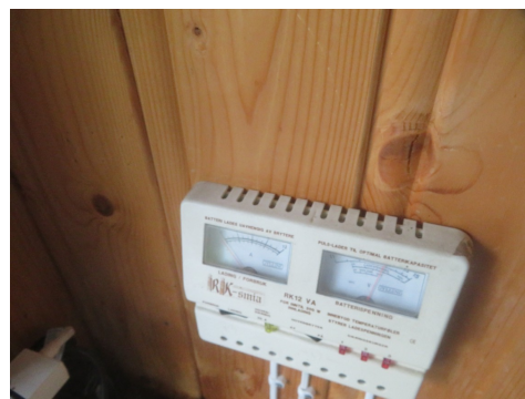
12 v styringspanel i hytta.
