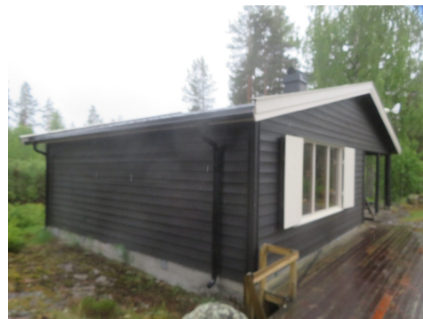
Vegger med liggende trepanel.
