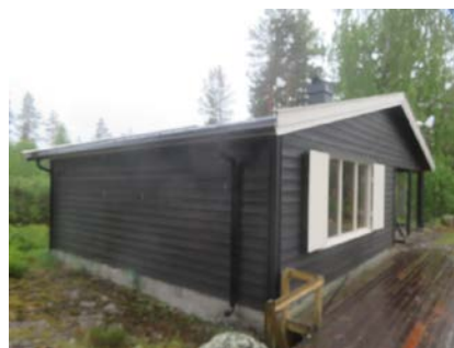
Vegger med liggende trepanel.
