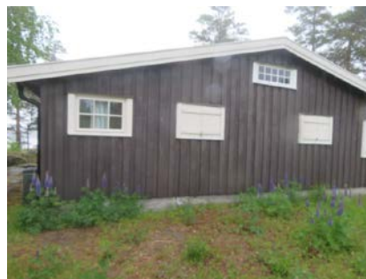
Vegg med stående trepanel.
