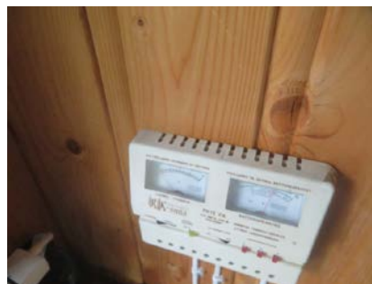
12 v styringspanel i hytta.
