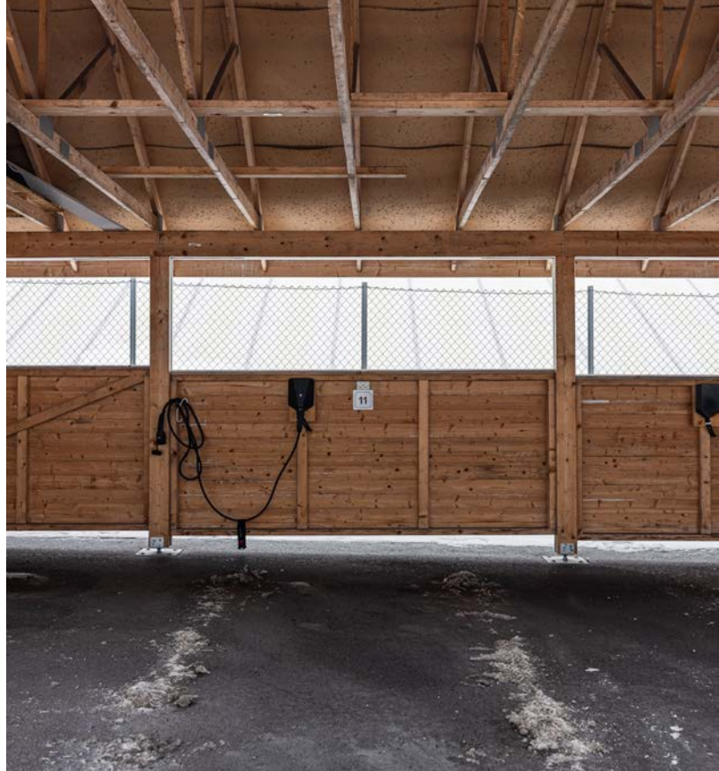
Det er biloppstillingsplass i felles carportanlegg. Elbil-lader er montert på plassen.
