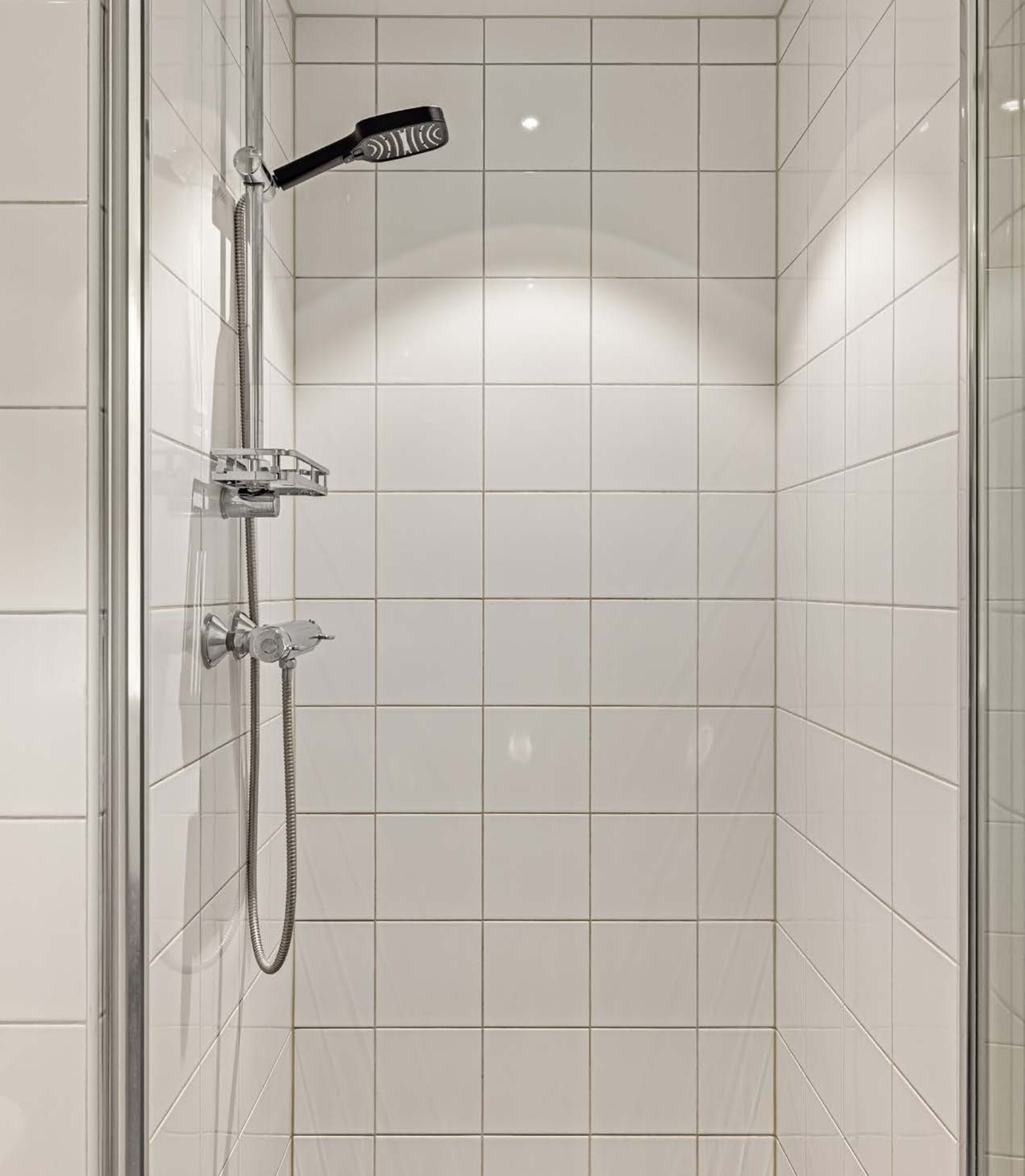
Dusjnische med dusjdør og veggmontert dusjbatteri.
