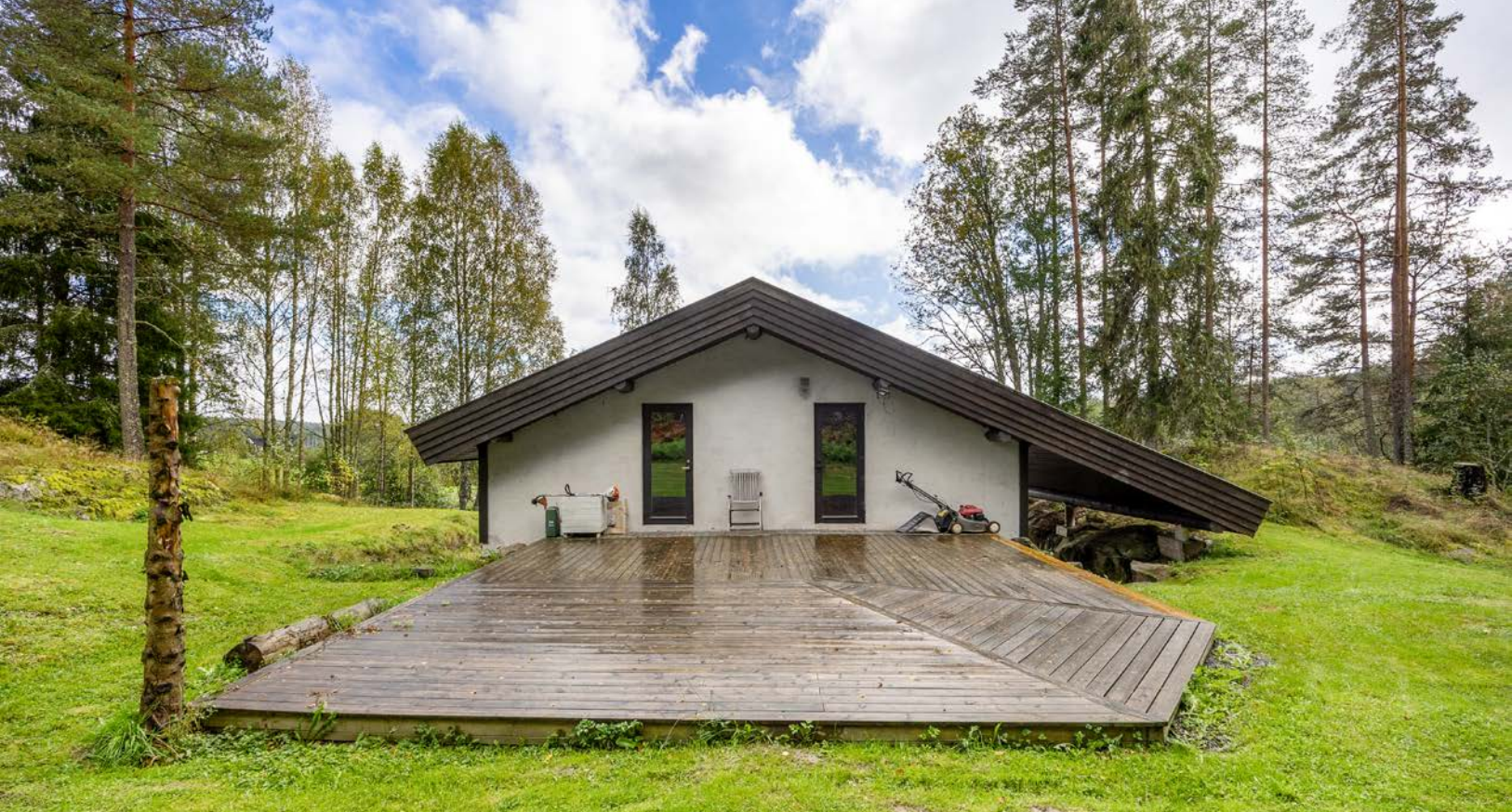
Mot nordvest er det en stor terrasseplattning med adkomst fra to av soverommene.
