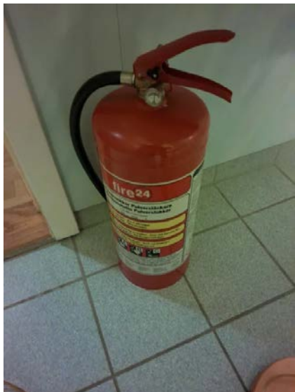
Brannslukningsapparat i leiligheten.
