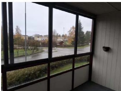
Oversiktsbilde innglasset balkong.
