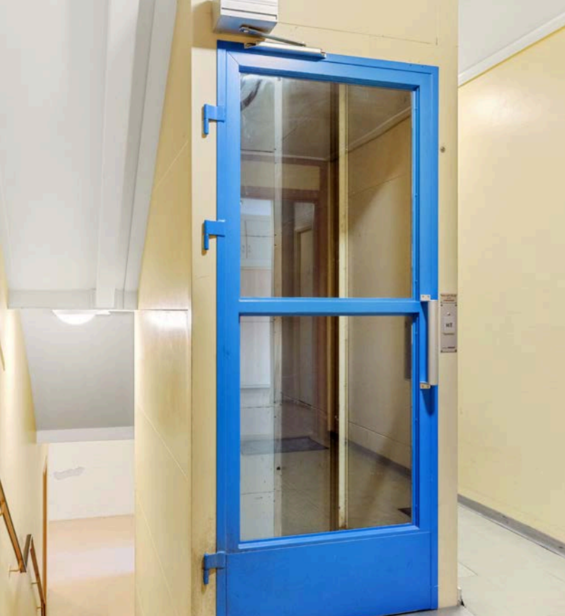
Felles trapperom med heis.
