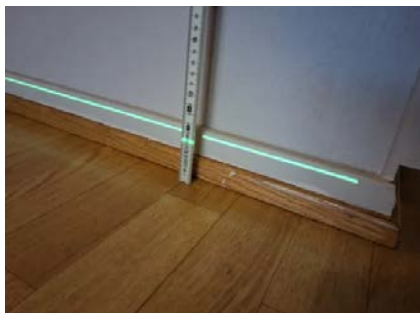
Etasjeskillet er kontrollert med nivelleringslaser.
