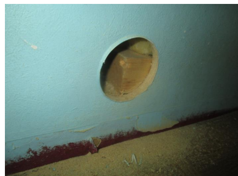
Hulltaking i fra soverom i mot bad/vaskerom.
