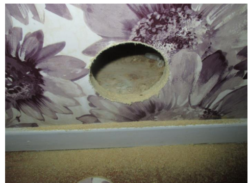
Hulltaking i fra toalettrom.
