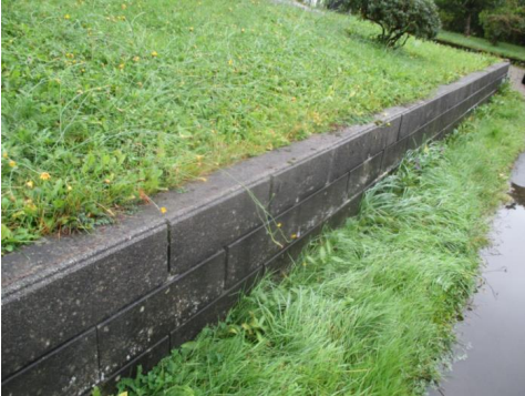
Noen mindre forstøtningsmurer i mot vei.
