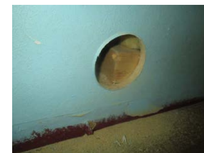
Hulltaking i fra soverom i mot bad/vaskerom.
