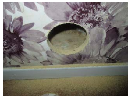
Hulltaking i fra toalettrom.
