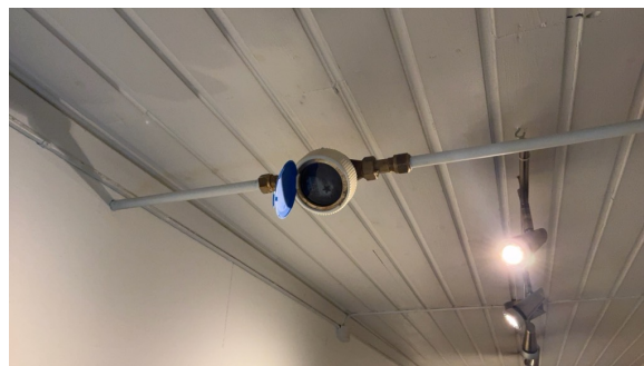
Ekstra vannmåler i gang i kjeller.
