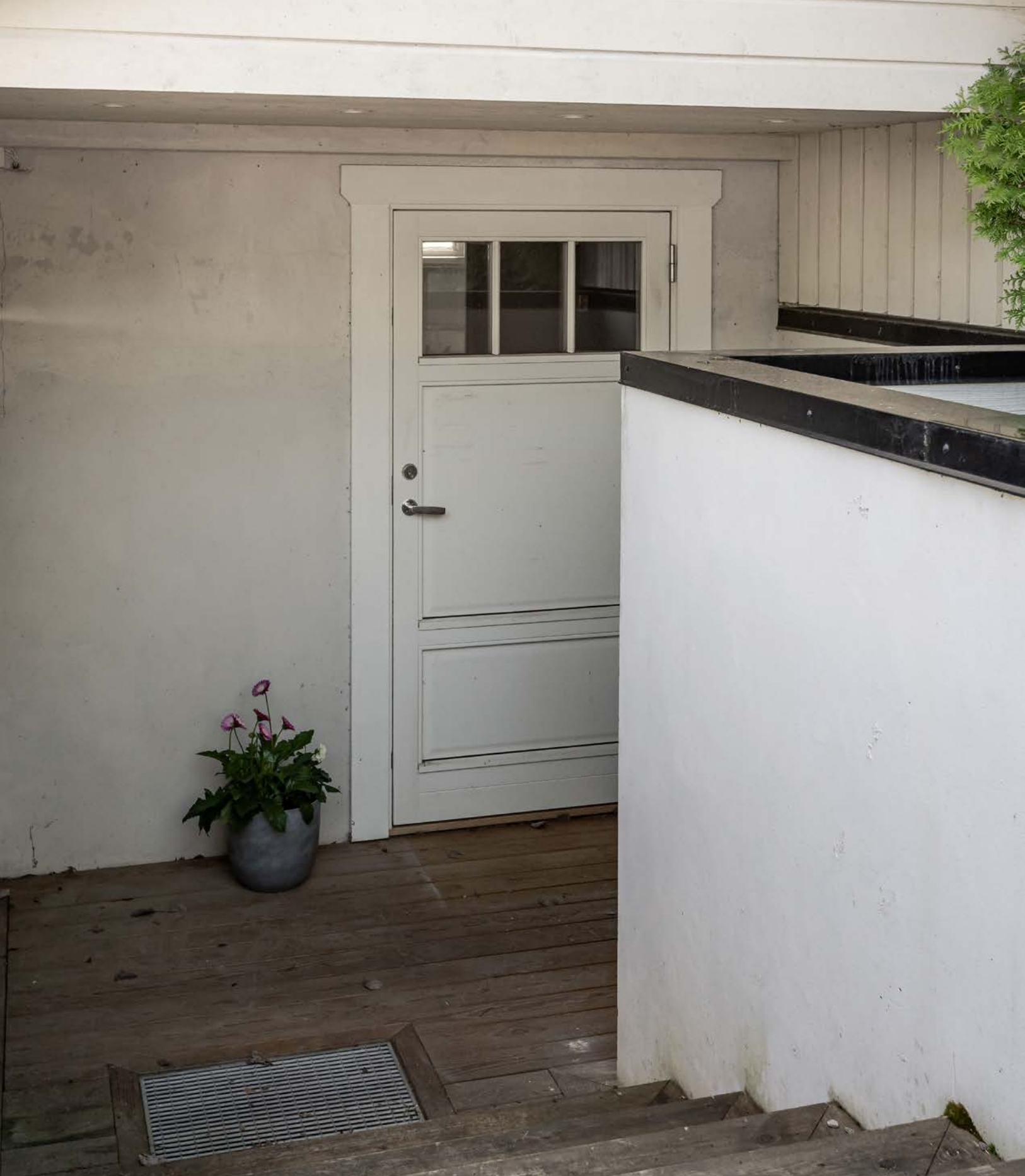
inggangen til kjelleren ble etablert i 2013.
