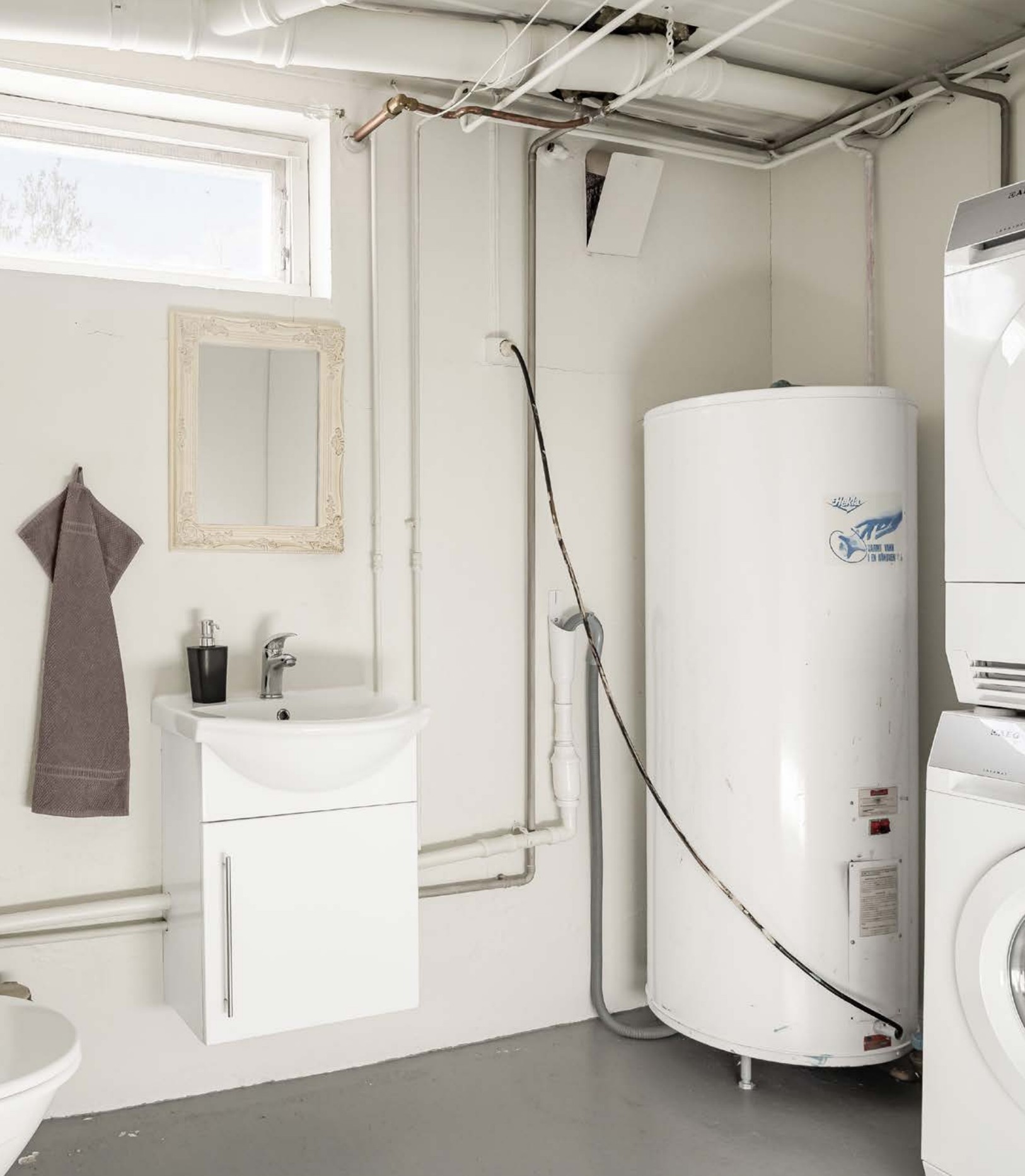
I kjelleren er det vaskerom, også utstyrt med toalett.
