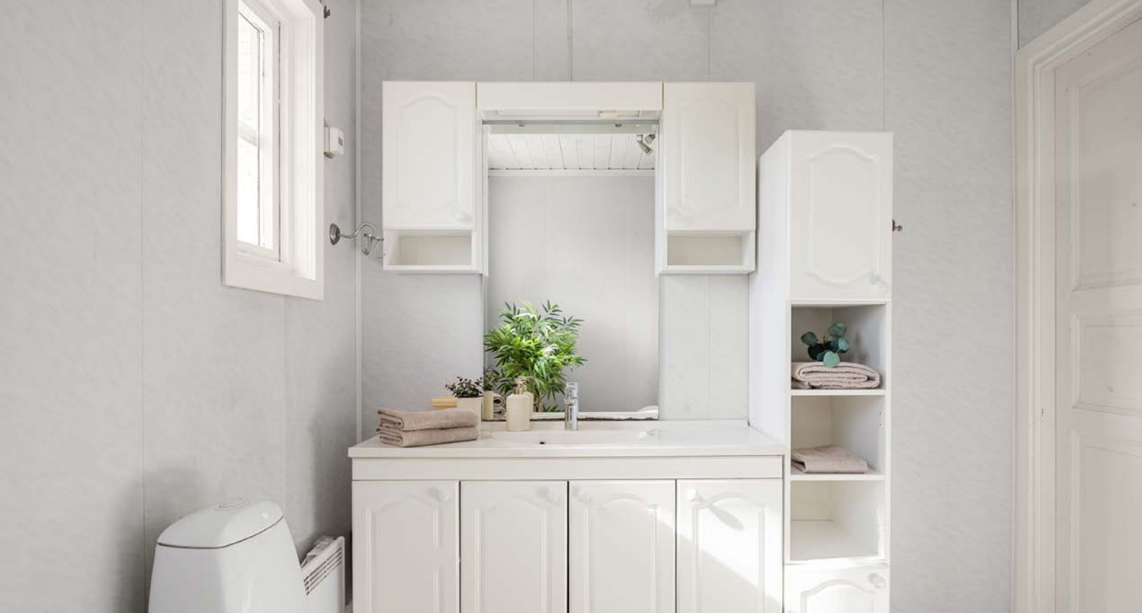
Romslig bad fra 1997 med belegg på gulvet og baderomsplater på veggene.
