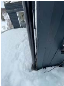
Frostspreng i enkelte taknedløp.
