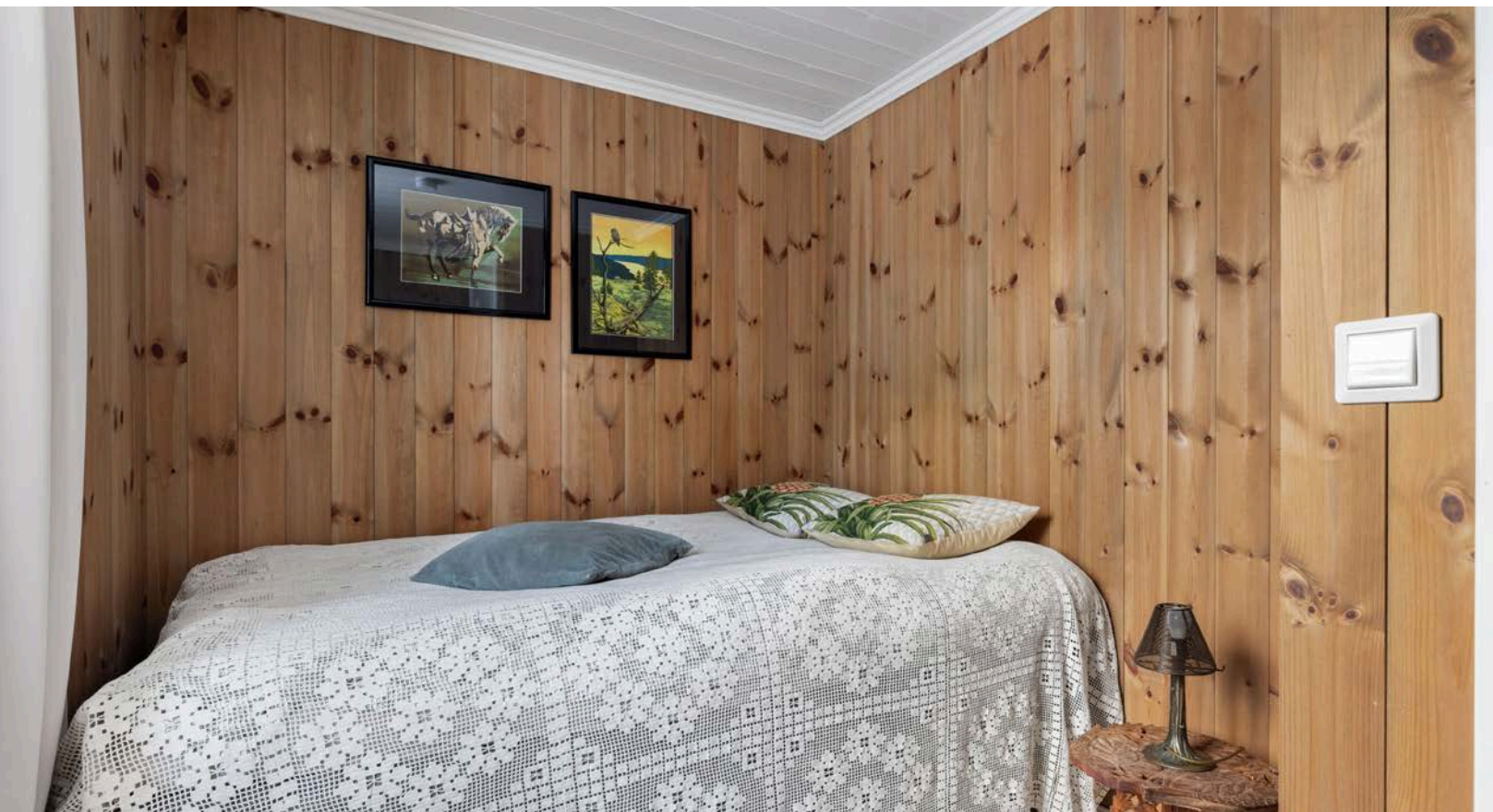
Soverommet med enstavs laminat på gulv, panel på veggene og skjult elektrisk anlegg.
