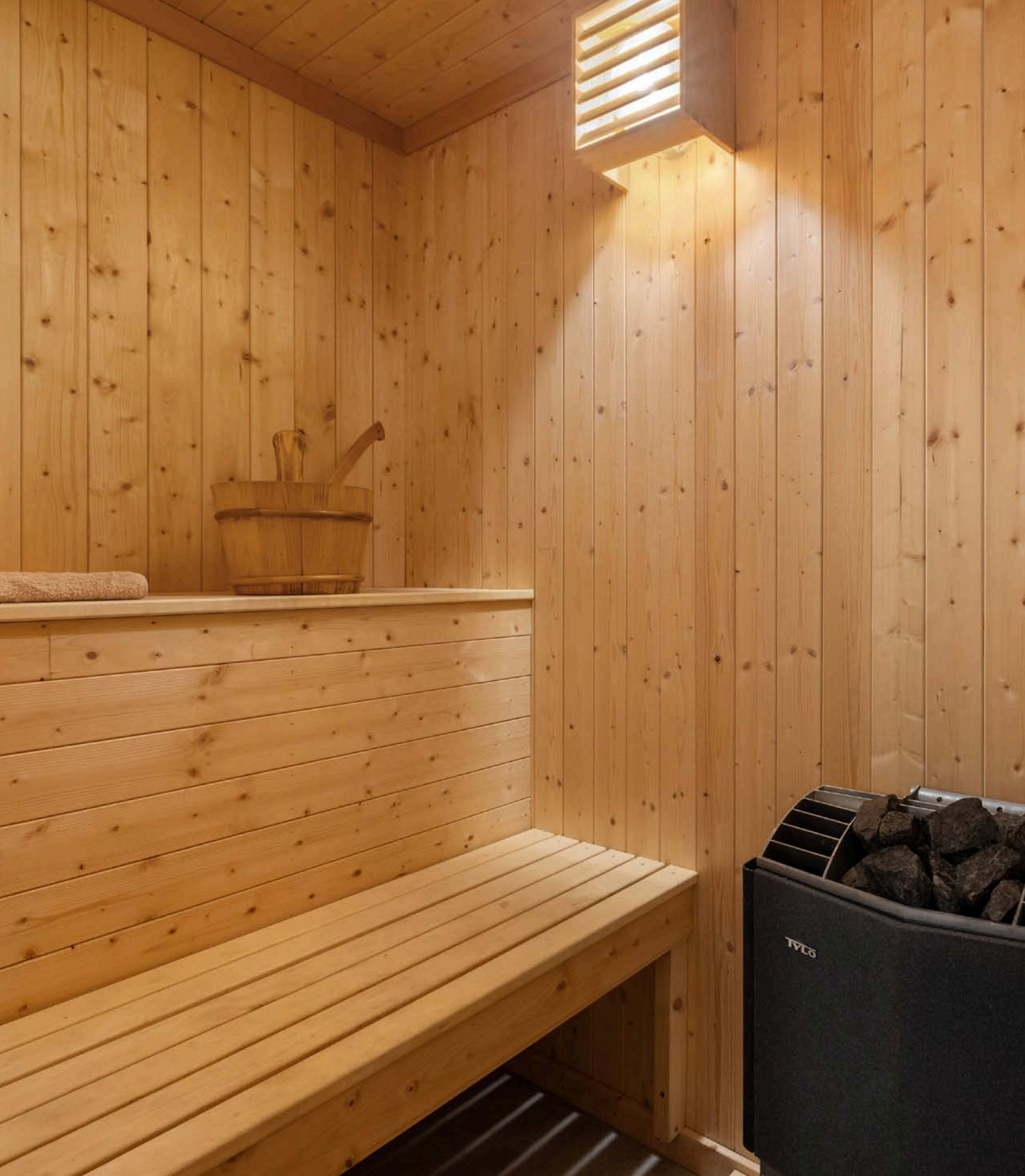
Badstuen har flislagt gulv, overflater med panel, plassbygde sittebenker og 6,6kW badstuovn.
