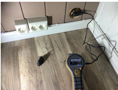
Hulltaking og fuktkontroll mot vaskerom/bad.
