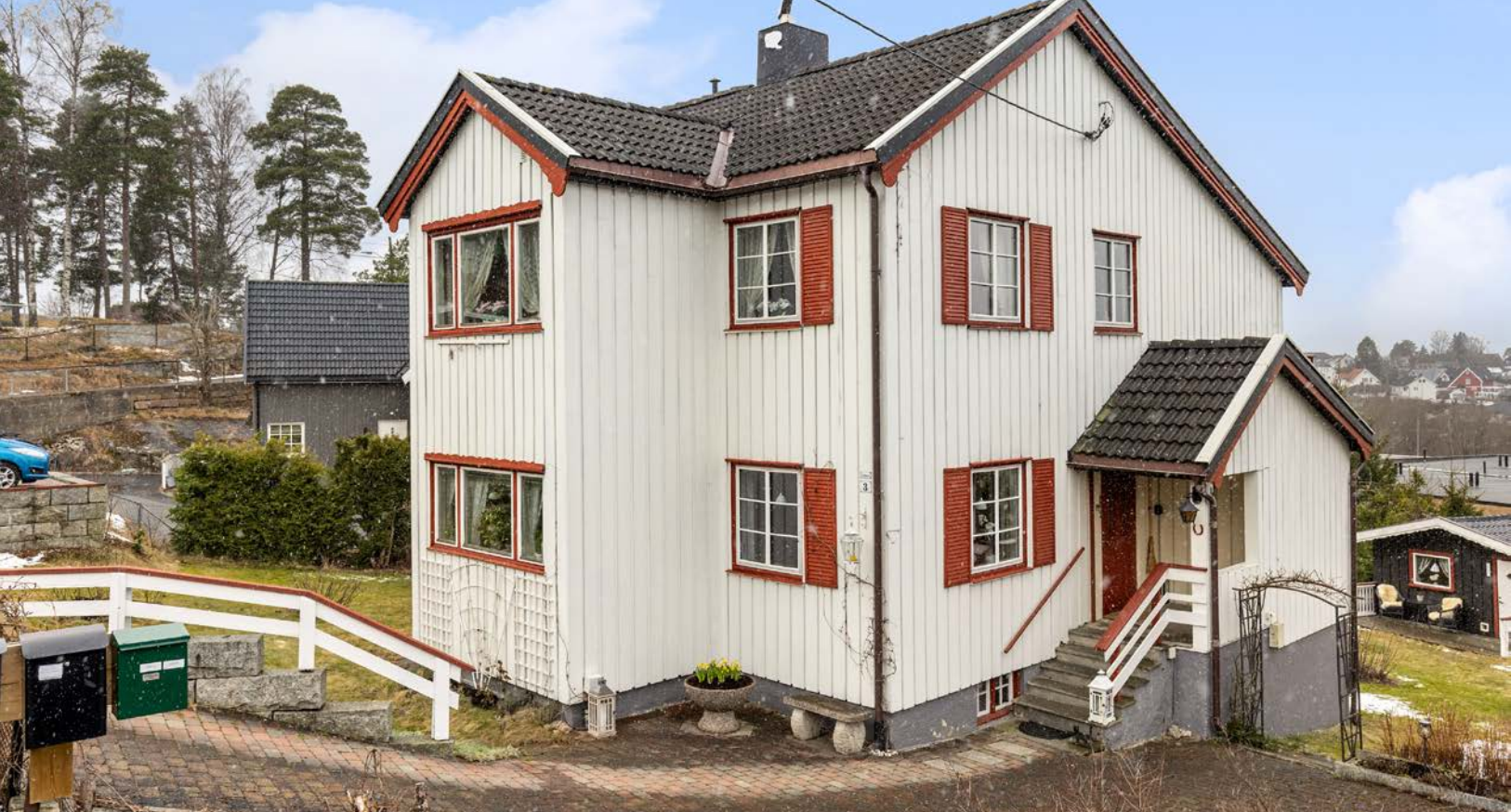
Den brostensbelagte adkomstveien fra veien og ned til huset har varmekabler
