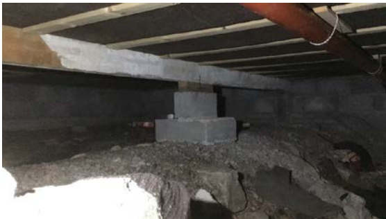
Gulv under tilbygg
