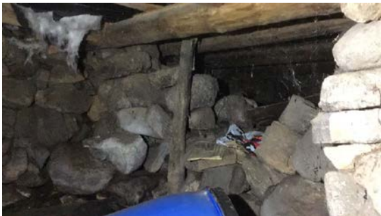
Kjeller under hovedhuset
