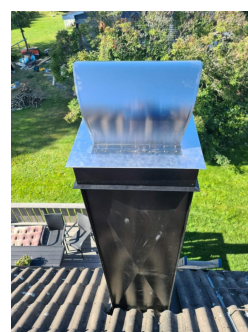
Nytt pipebeslag er montert i etterkant av befaringen.
