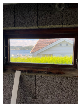
Vindu i stue har slitasje og symptomer etter kondensering
