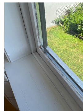
Vindu i stue har slitasje og symptomer etter kondensering
