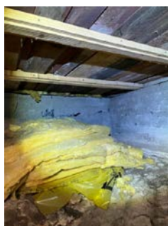
Mur mellom gammel og ny del av kjelleren
