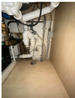
Rørapplegg i kjøkkenbenk med Waterguard
