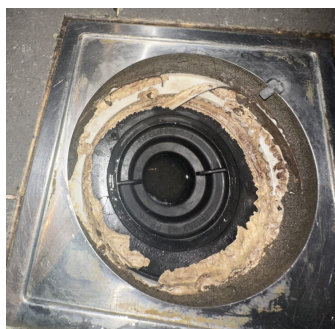
Sluk i plast, plassert i dusjnise
