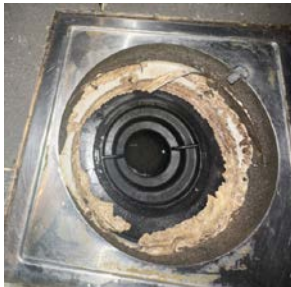
Sluk i plast, plassert i dusjnise
