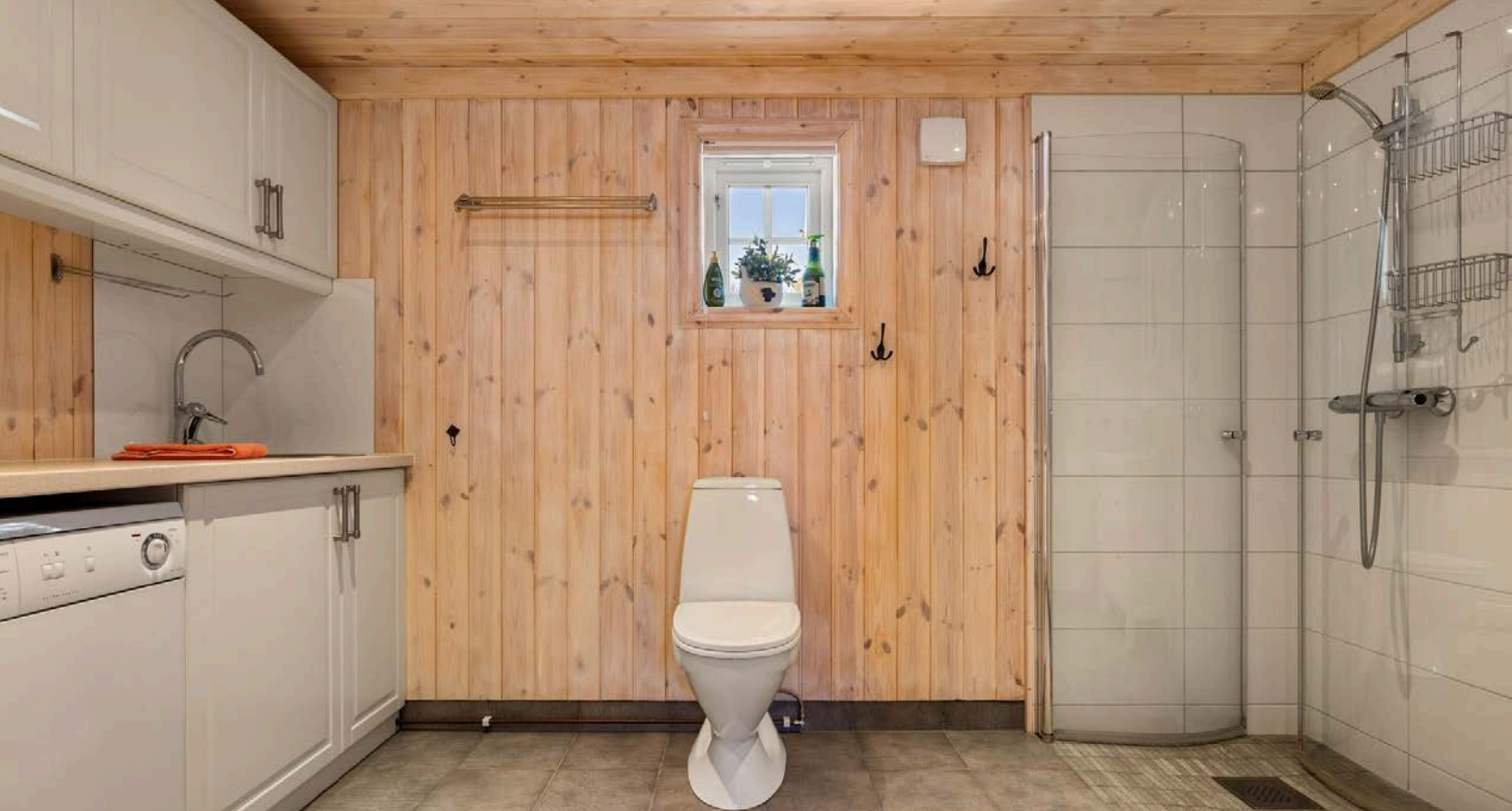
Hytta har et romslig og praktisk bad/vaskerom fra byggeåret 2016. Baderommet har flislagt gulv med gulvvarme, trepanel på veggene kombinert med fliser i dusjsonen og downlights i himlingen.
