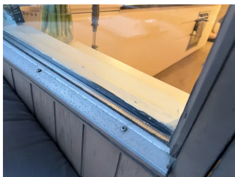
Vindu ved balkong.
