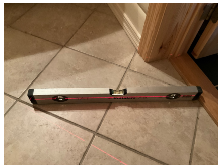
Motfall på deler av gulvet.
