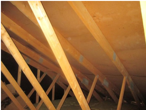
Deler av takkonstruksjonen.
