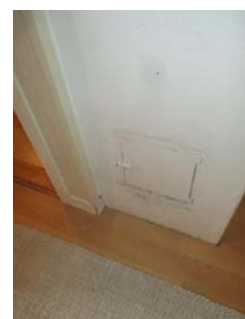
Sotluke i gangen i underetasjen.
