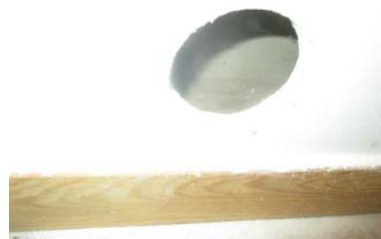
Hulltaking i fra bod under trapp.
