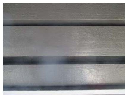
Bra med tilgang på luft i fra gesimser.
