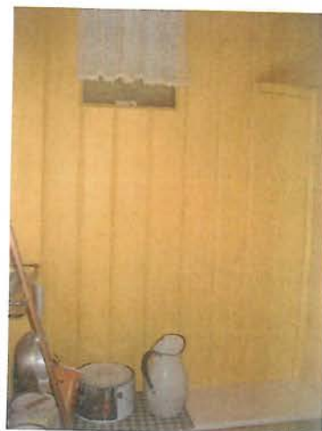
Opprinnelig paneltype. Foto: Anette Mehren NIKU 2006.
