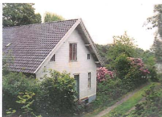
Vestre gavlvegg og hagen. Opphavsrett: Tollvesenet.
