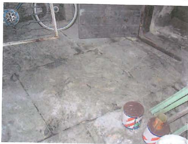
Hellelagt gulv i kjelleren. Foto: Anette Mehren NIKU 2006.
