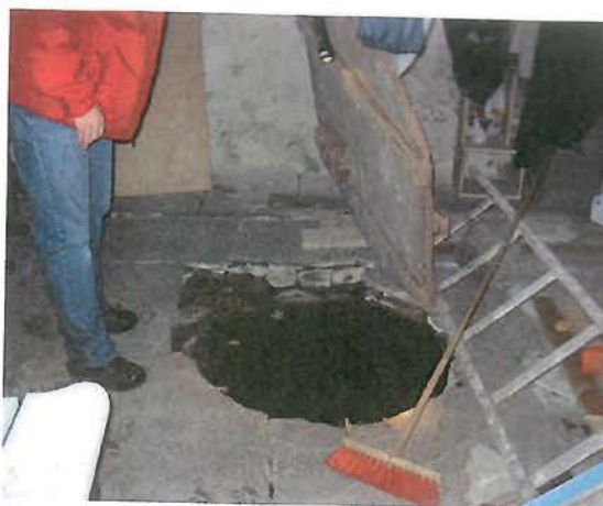
Brønn i bryggerhuset i kjelleren. Foto: Anette Mehren NIKU 2006.
