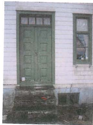
Hovedinngang på østre gavivegg. Foto: Anette Mehren NIKU 2006.
