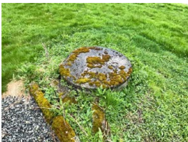
Kumlokk til tanken.
