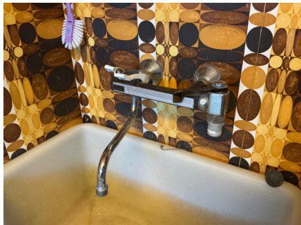
Blandebatteri fra byggeår på vaskerom
