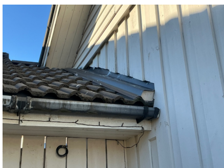
Beslag er ikke fagmessig utført.
