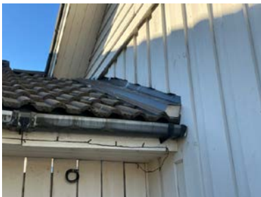
Beslag er ikke fagmessig utført.
