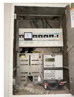
Sikringsskap med automatsikringer.
