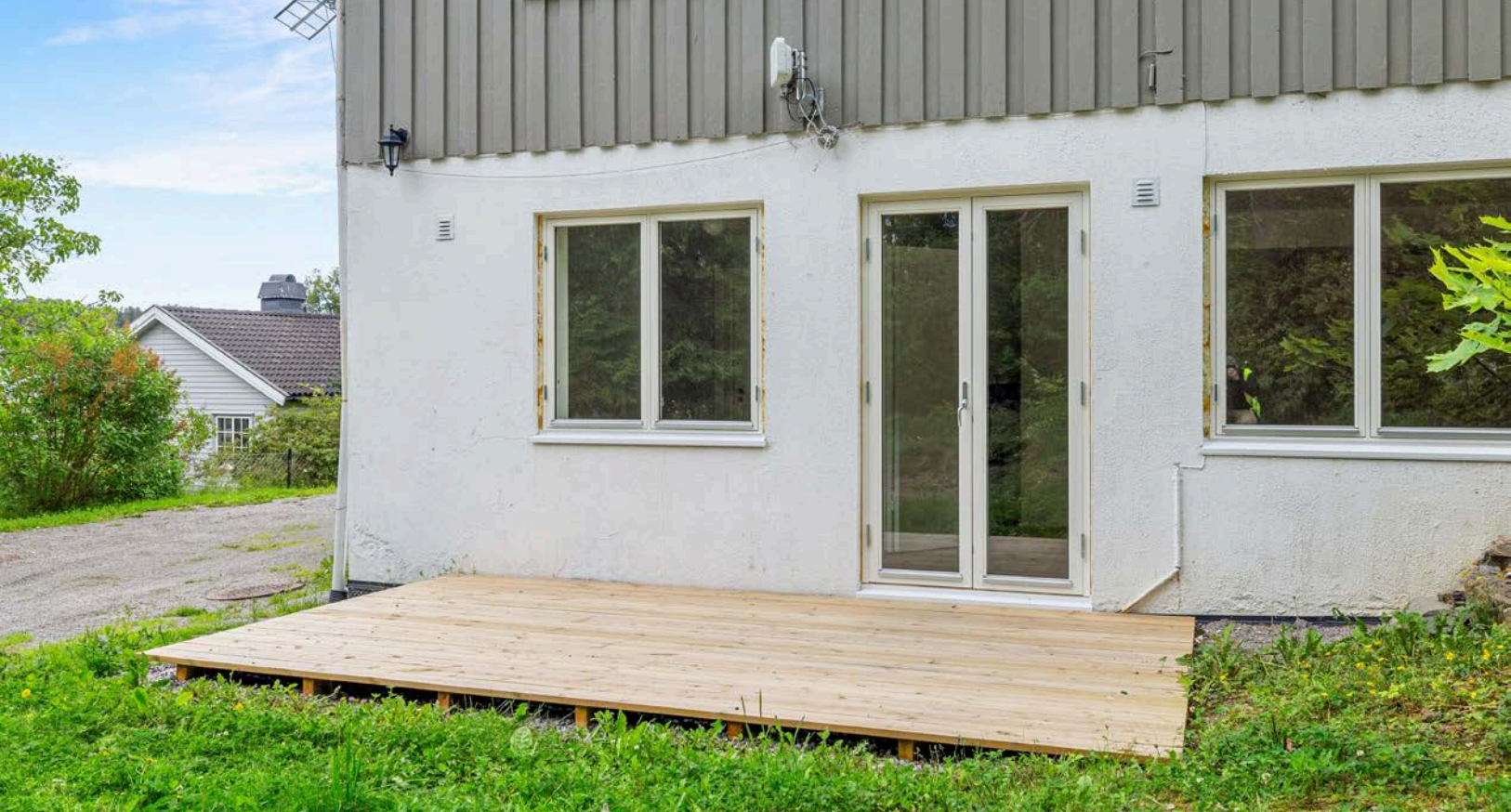
I stuen er det doble terrassedører fra 2025 ut til en ny terrasseplattning.
