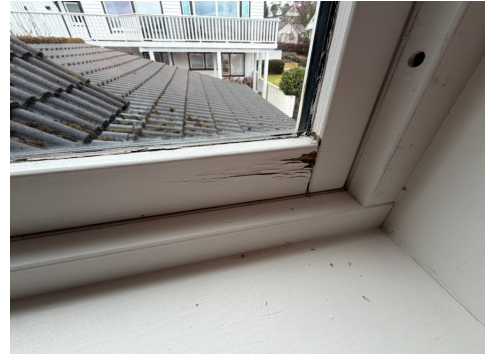
Vindu på bad 2 etasje.
