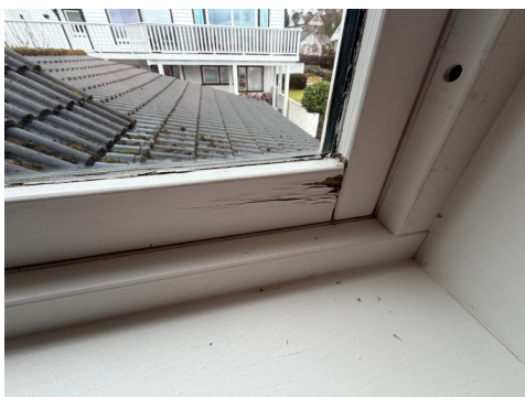
Vindu på bad 2 etasje.
