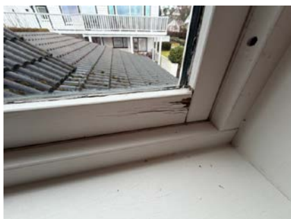
Vindu på bad 2 etasje.
