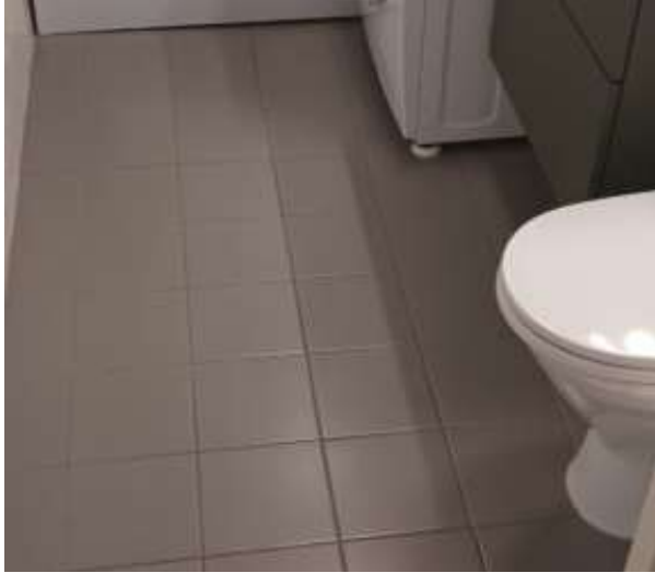
Bilde 1 Ingen kalde områder, sjekket med termo kamera.
