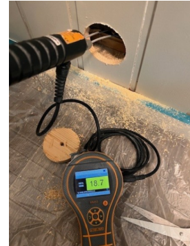
Fuktmåling i vegg mot påforet grunnmur som ligger mot terreng.
