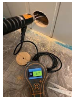
Fuktmåling i vegg mot påforet grunnmur som ligger mot terreng.
