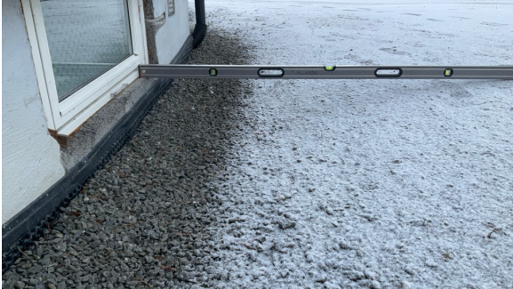
Fall mot grunnmur fra nord.
