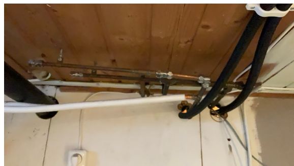
Noe åpent anlegg på vannrør i bod i kjeller
