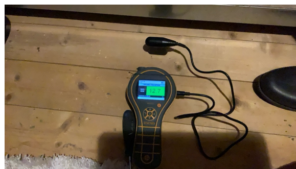
Fuktmåling i tregulv.
