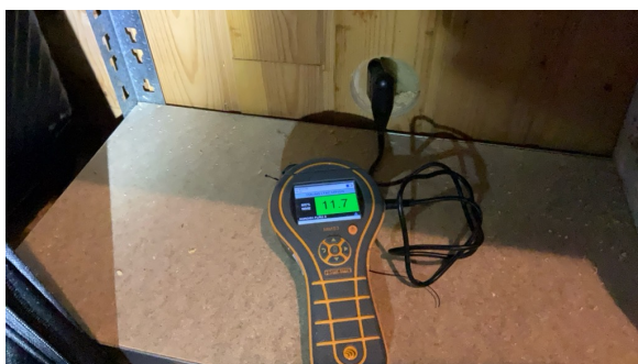
Fuktmåling i bod.
