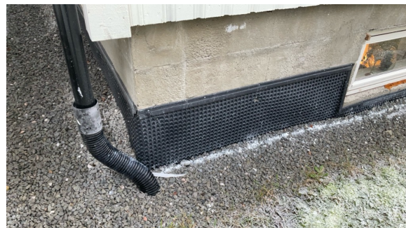
Grunnmursplast avsluttet over terreng.
