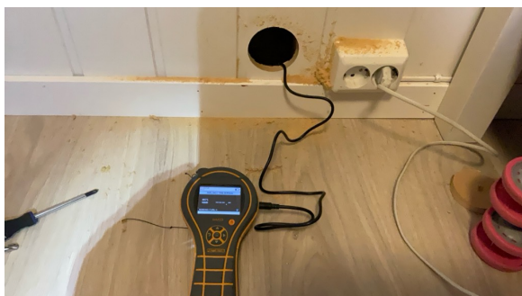
Fuktmåling i konstruksjon mot bad.
