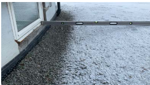
Fall mot grunnmur fra nord.
