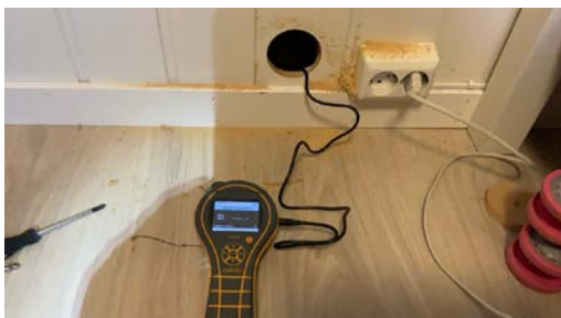
Fuktmåling i konstruksjon mot bad.
