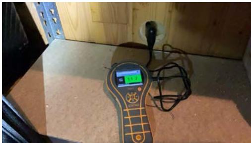
Fuktmåling i bod.
