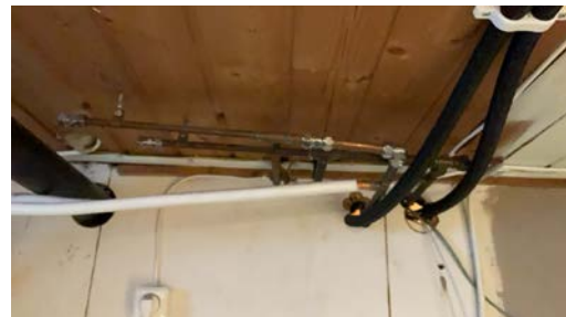
Noe åpent anlegg på vannrør i bod i kjeller
