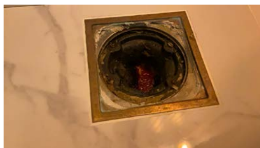
Sluk i gulv.
