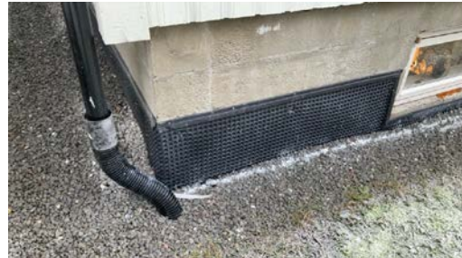
Grunnmursplast avsluttet over terreng.
