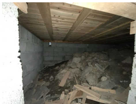
Besiktigelse av kryprom.
