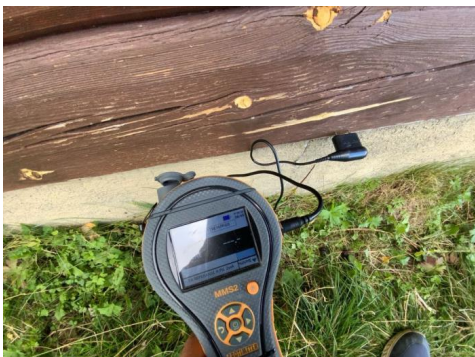
Utført fuktmåling i bunnstokk. Ingen tegn til fukt på befaringsdagen.
