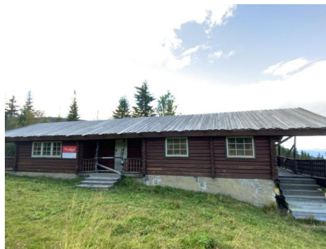
Besiktigelse av taktekke.
