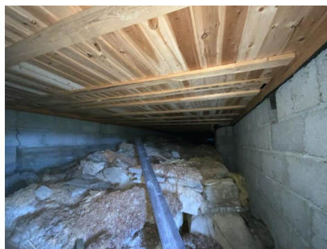
Besiktigelse av kryprom.
