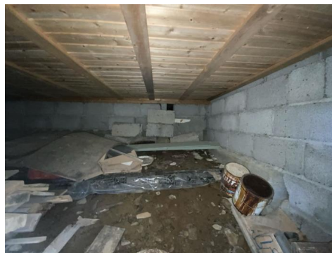
Besiktigelse av kryprom.
