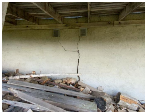
Synlige setningsskader.
