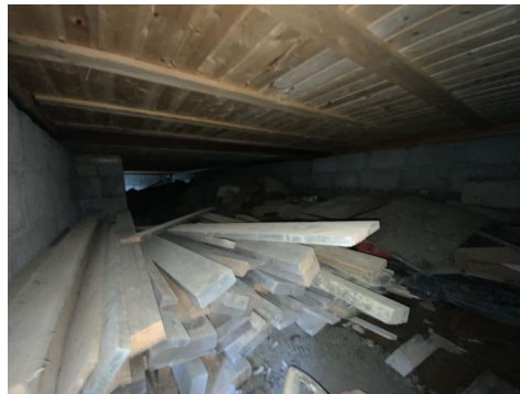
Besiktigelse av kryprom.
