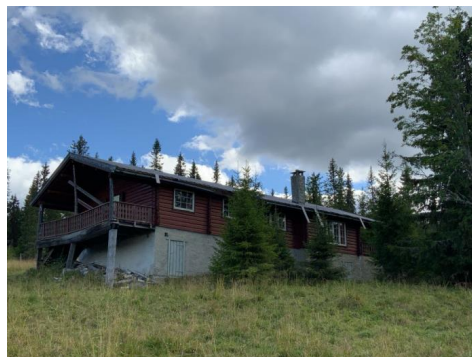
Besiktigelse av taktekke.
