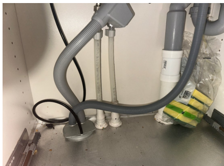
Røropplegg i kjøkkenbenk med Waterguard
