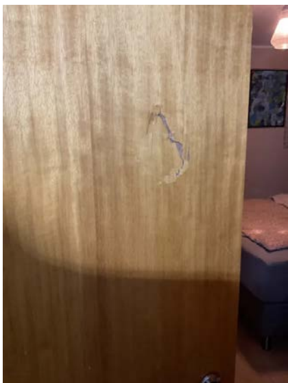
Hull i dør.
