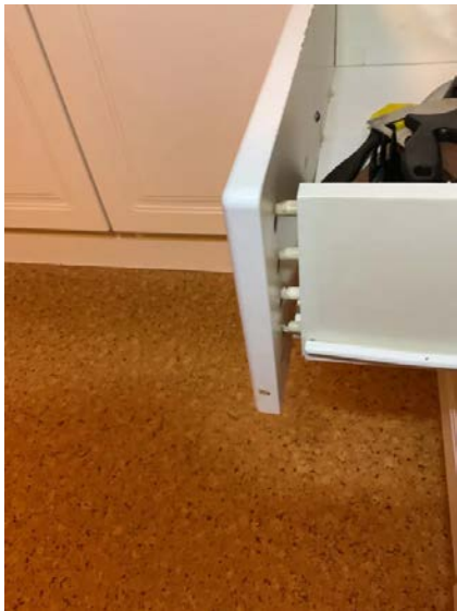
Slittasje/skade på kjøkken.
