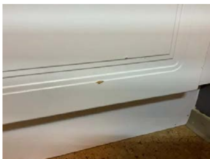
Slittasje/skade på kjøkken.
