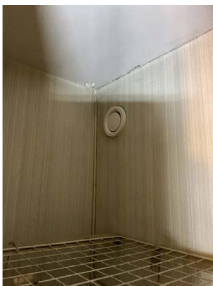
Ventil i vegg på bad.
