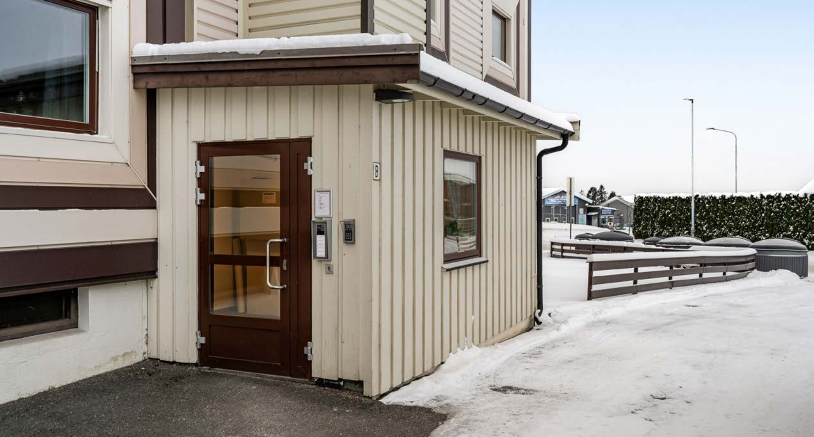
Inngang til leiligheten via felles inngangsparti med callinganlegg og heis.
