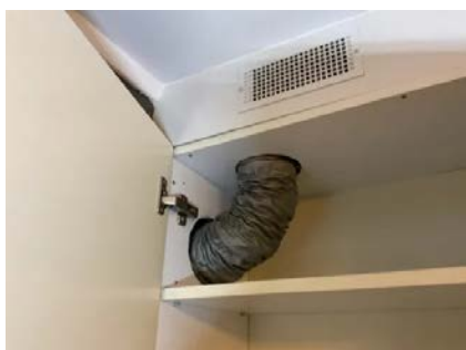
Lufferist på kjøkken.
