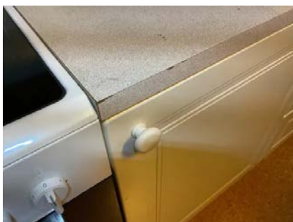
Slittasje/skade på kjøkken.
