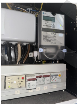
Sikringsskap med automatsikringer.
