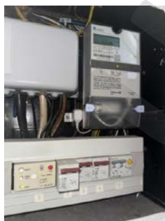
Sikringsskap med automatsikringer.
