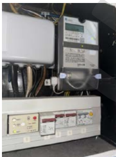
Sikringsskap med automatsikringer.
