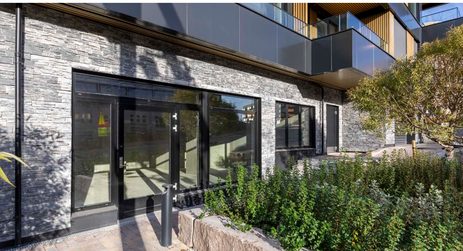
Lokalene ligger i 1 etasje i bygg oppført 2023/2024
